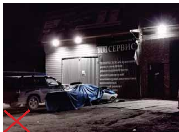
Недопустимо устанавливать светильники (прожекторы) со слепящим эффектом.
